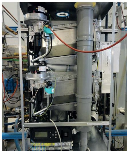
(до 109% согласно стандартной методике расчетов по низшей теплоте сгорания топлива). Для этого в конструкции конденсационного котла предусмотрен специальный теплообменник, в котором происходит охлаждение дымовых газов и, в частности, водяного пара, образующегося при сгорании газа, до температуры точки росы. При этом фазовом переходе и происходит дополнительное выделение энергии.
